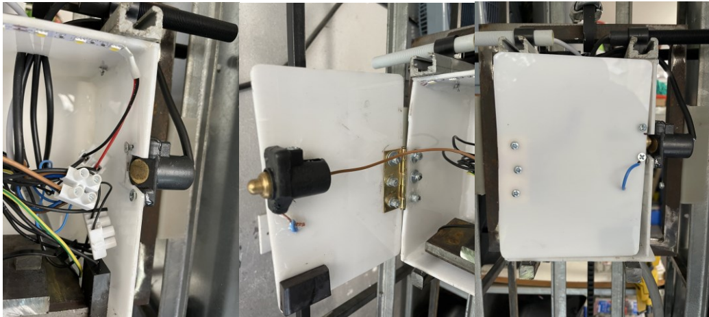
Εικόνα 5-12 Πόρτα Θαλάμου και επαφή ασφαλείας
