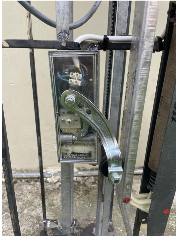
Εικόνα 5-10 Κλειδαριά ασφαλείας και ηλεκτρομαγνήτης
