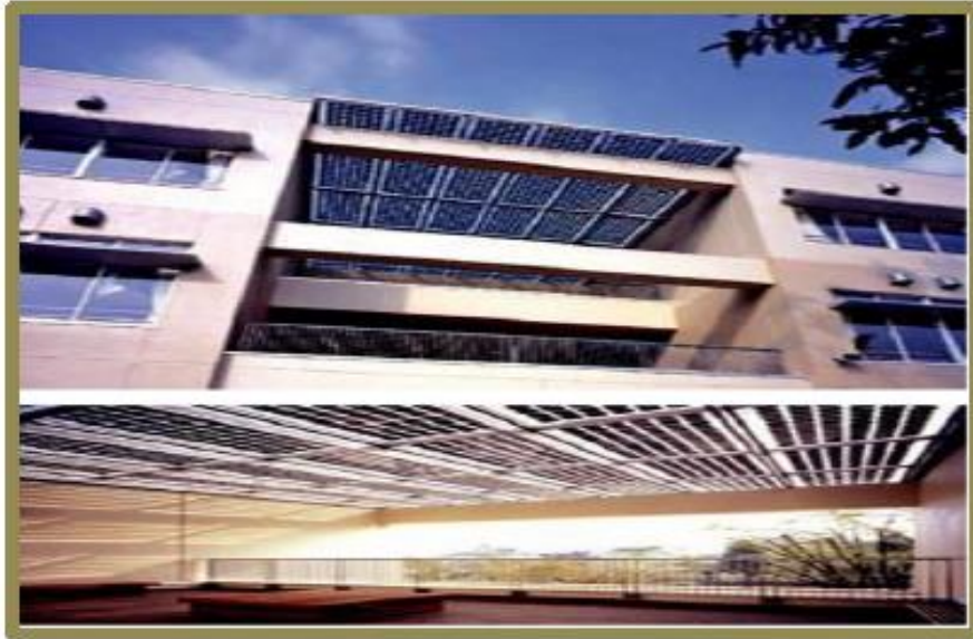
Εικόνα 27: Φωτοβολταϊκά σε πέργκολα (Πηγή: Pure Project).
