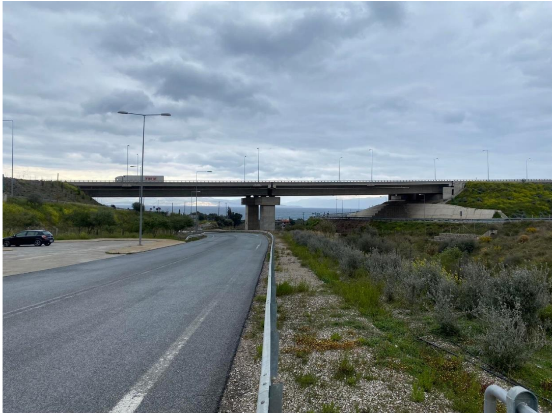
Φωτογραφία 5.31 Πλάγια όψη γέφυρας, μετά την περάτωση των εργασιών. Λήψη 2022.
