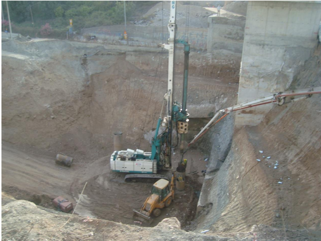
Φωτογραφία 5.5 Μηχάνημα εκσκαφής φρεατοπασσάλων.
