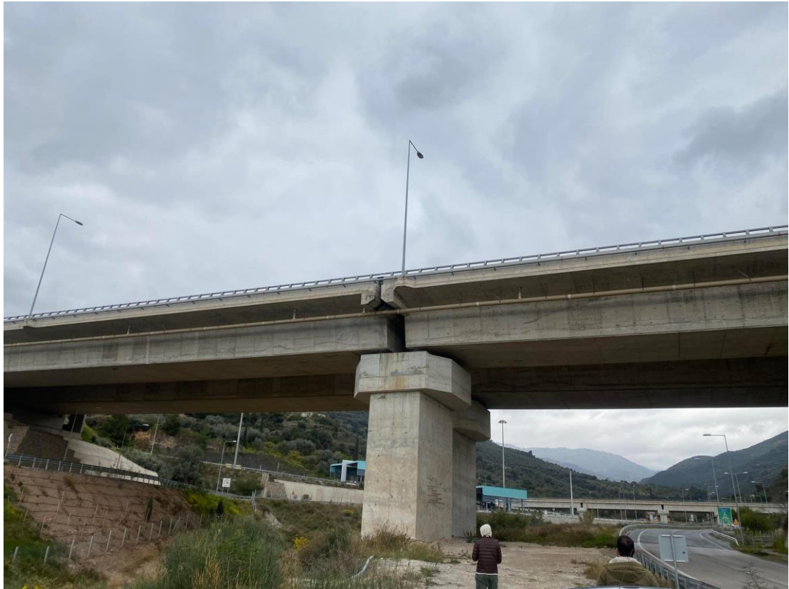
Φωτογραφία 5.36 Μεσόβαθρα, μετά την περάτωση των εργασιών. Λήψη 2022.
