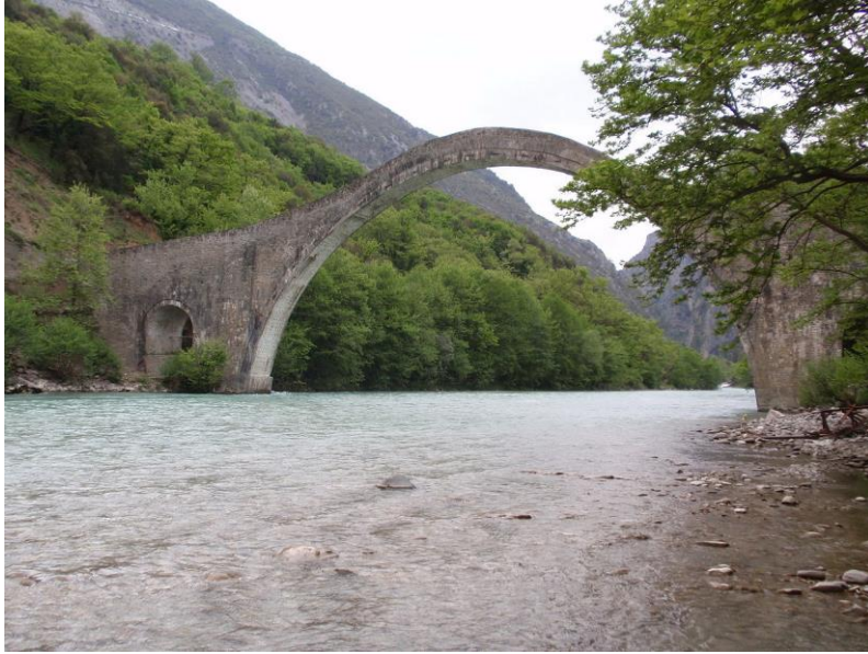
Εικόνα 1.1. Το γεφύρι της πλάκας, πέτρινο τοξωτό γεφύρι στον Άραχθο ποταμό, χτισμένο το 1866 [link 1].
