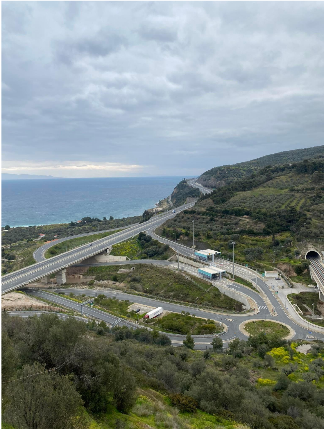
Φωτογραφία 5.34 Πανοραμική όψη της γέφυρας, μετά την περάτωση των εργασιών. Λήψη 2022.
