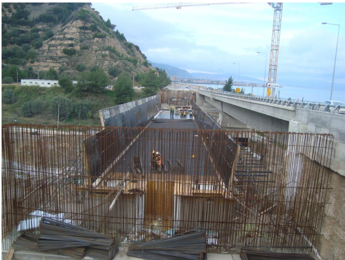
Φωτογραφία 5.8 Τοποθέτηση ξυλότυπου ανοίγματος.
