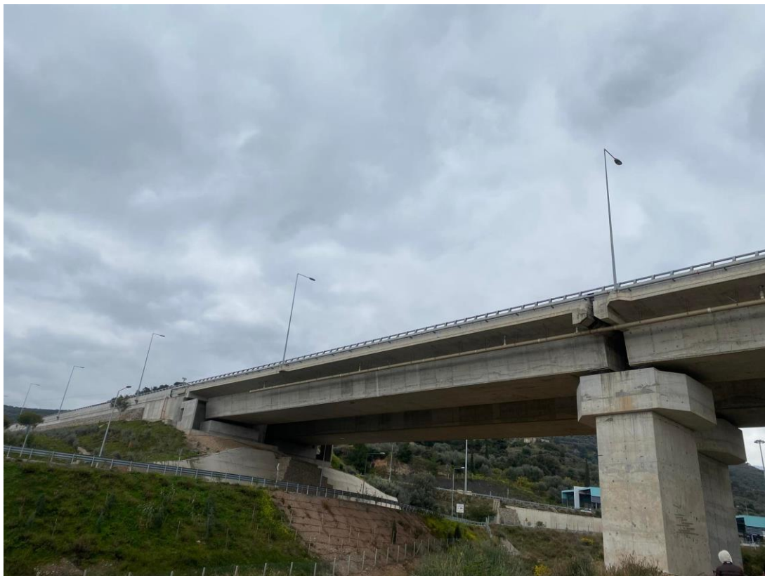
Φωτογραφία 5.31 Αριστερό ακρόβαθρο, μετά την περάτωση των εργασιών. Λήψη 2022.
