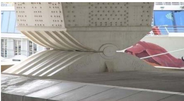
Εικόνα 1.17. Αρθρωτό εφέδρανο [link 17].
