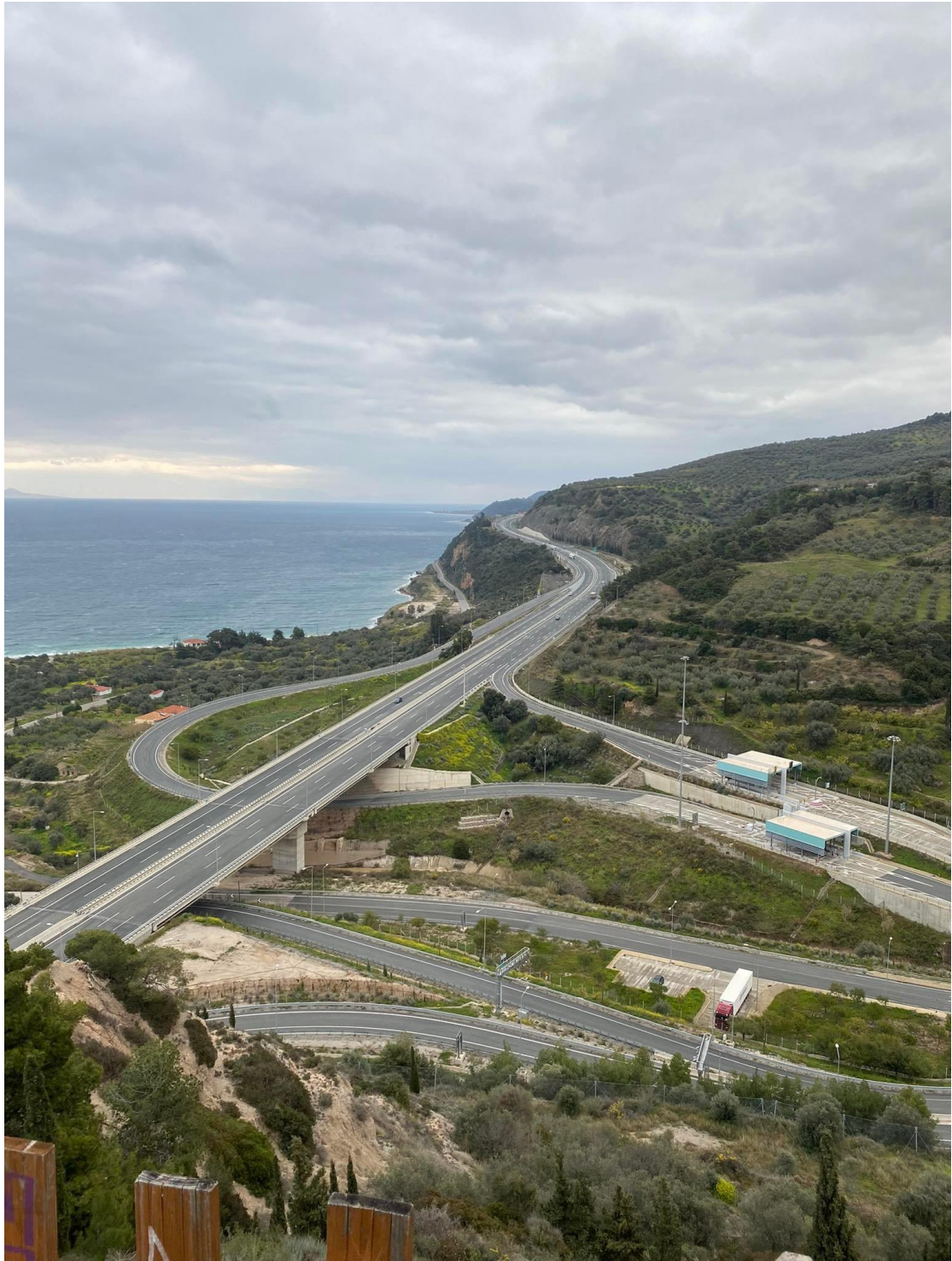
Φωτογραφία 5.38 Πανοραμική όψη της γέφυρας, μετά την περάτωση των εργασιών. Λήψη 2022.
