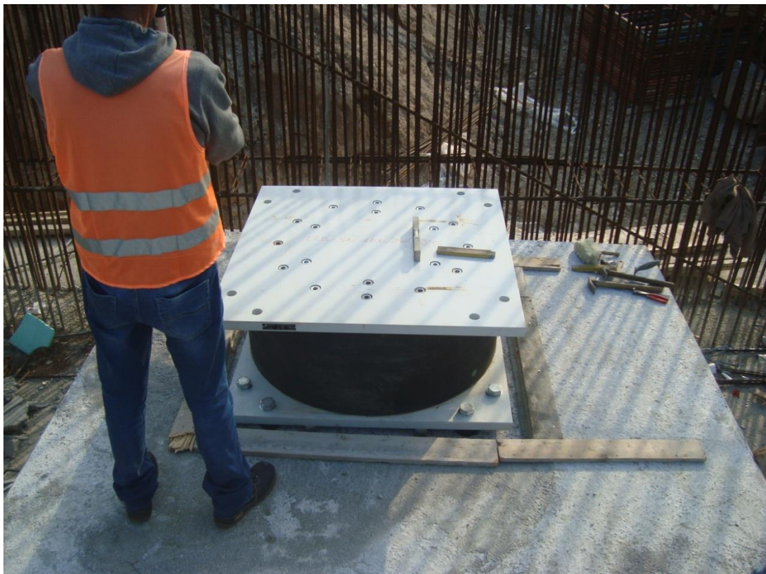
Φωτογραφία 5.16 Τοποθέτηση εφέδρανου.
