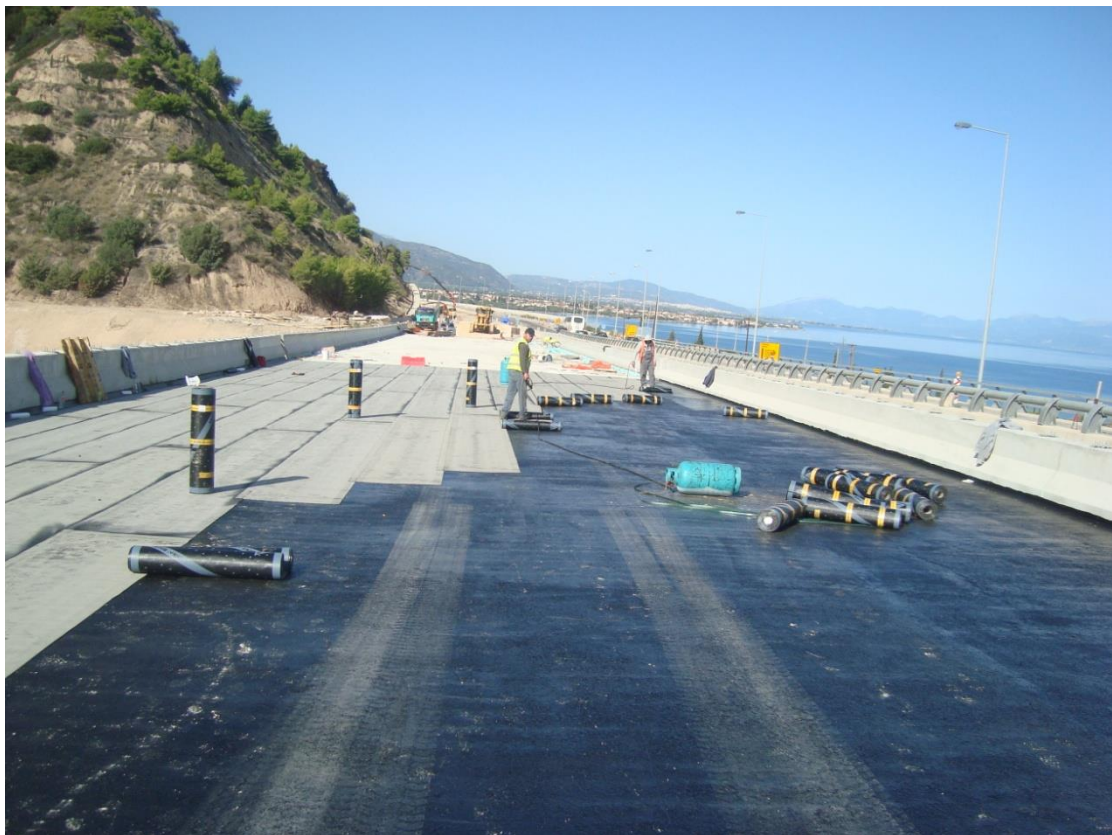
Φωτογραφία 5.20 Τοποθέτηση μόνωσης της πλάκας του καταστρώματος.
