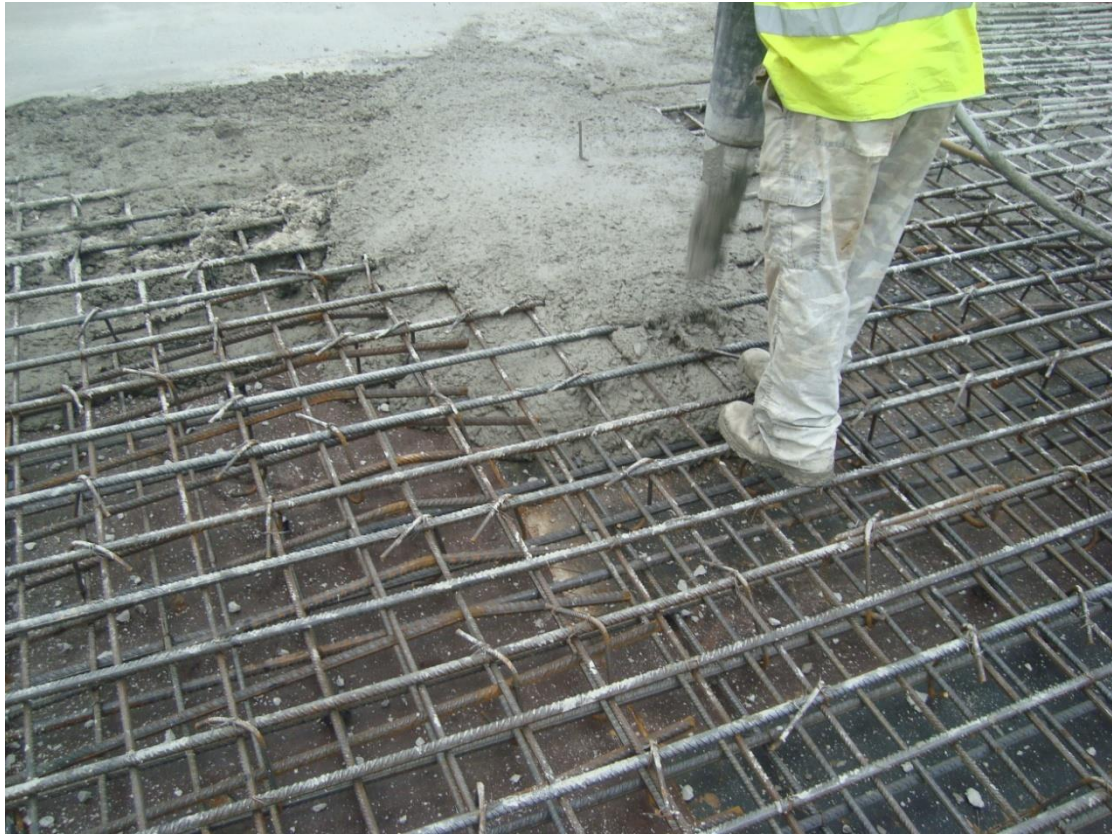
Φωτογραφία 5.11 Σκυροδέτηση ανοίγματος - στόμιο πρέσας.
