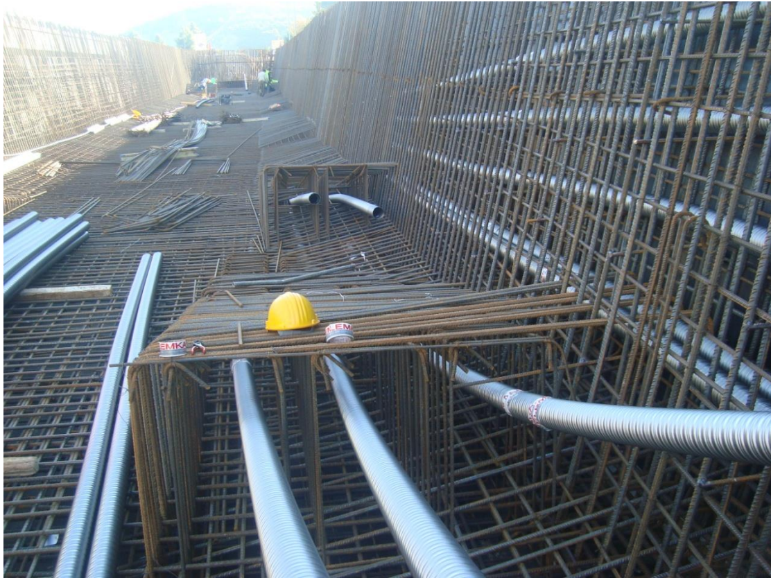
Φωτογραφία 5.9 Οπλισμοί ανοίγματος – τένοντες.
