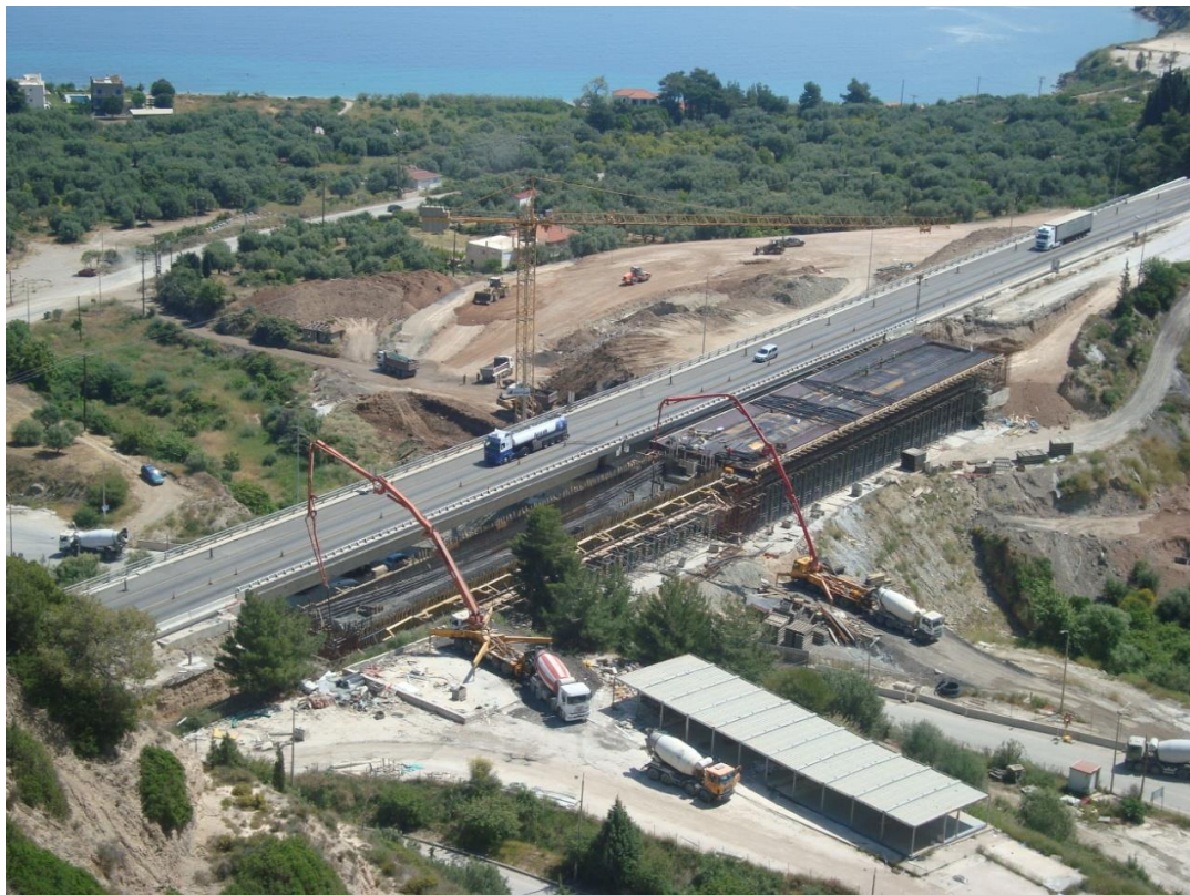
Φωτογραφία 5.30 Όψη κατά την κατασκευή του δεξιού κλάδου.
