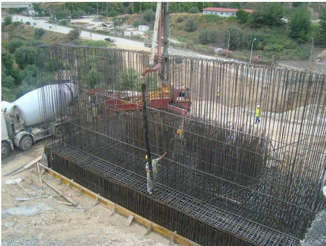
Φωτογραφία 5.2 Οπλισμός θεμελίωσης ακρόβαθρου Μ0.
