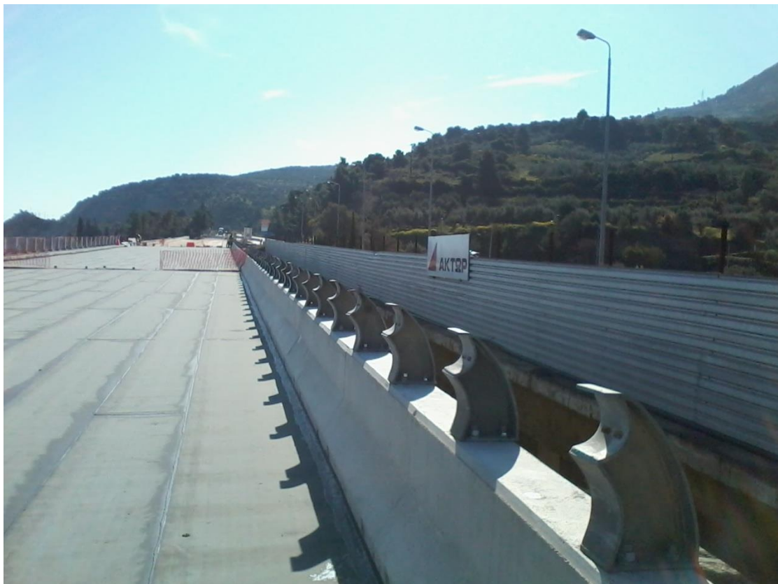
Φωτογραφία 5.26 Τοποθέτηση παράλληλων προστατευτικών μπαρών.
