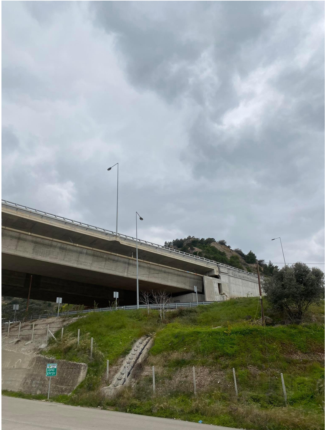
Φωτογραφία 5.33 Δεξιό ακρόβαθρο, μετά την περάτωση των εργασιών. Λήψη 2022.
