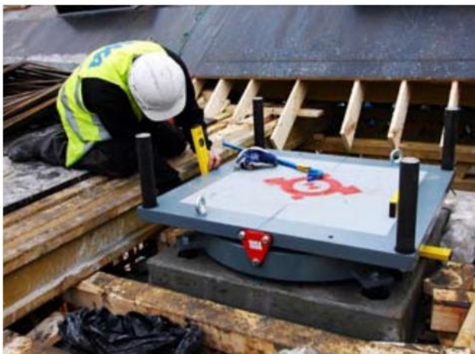
Εικόνα 1.19. Εφέδρανα σημειακού τύπου [link 19].
