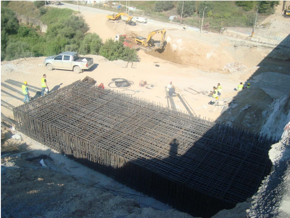
Φωτογραφία 5.1 Οπλισμός θεμελίωσης ακρόβαθρου Μ0.
