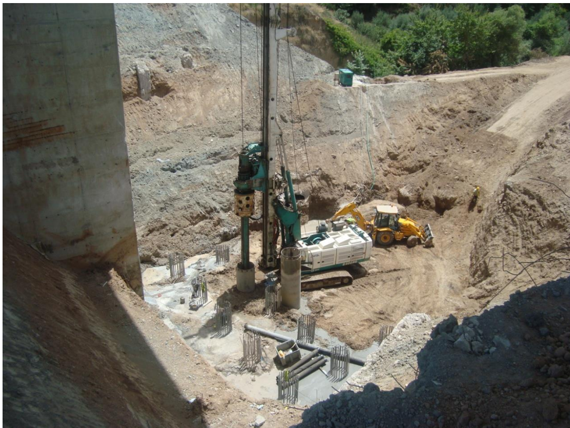
Φωτογραφία 5.6 Δημιουργία φρεατοπασσάλων στο μεσόβαθρο M2.
