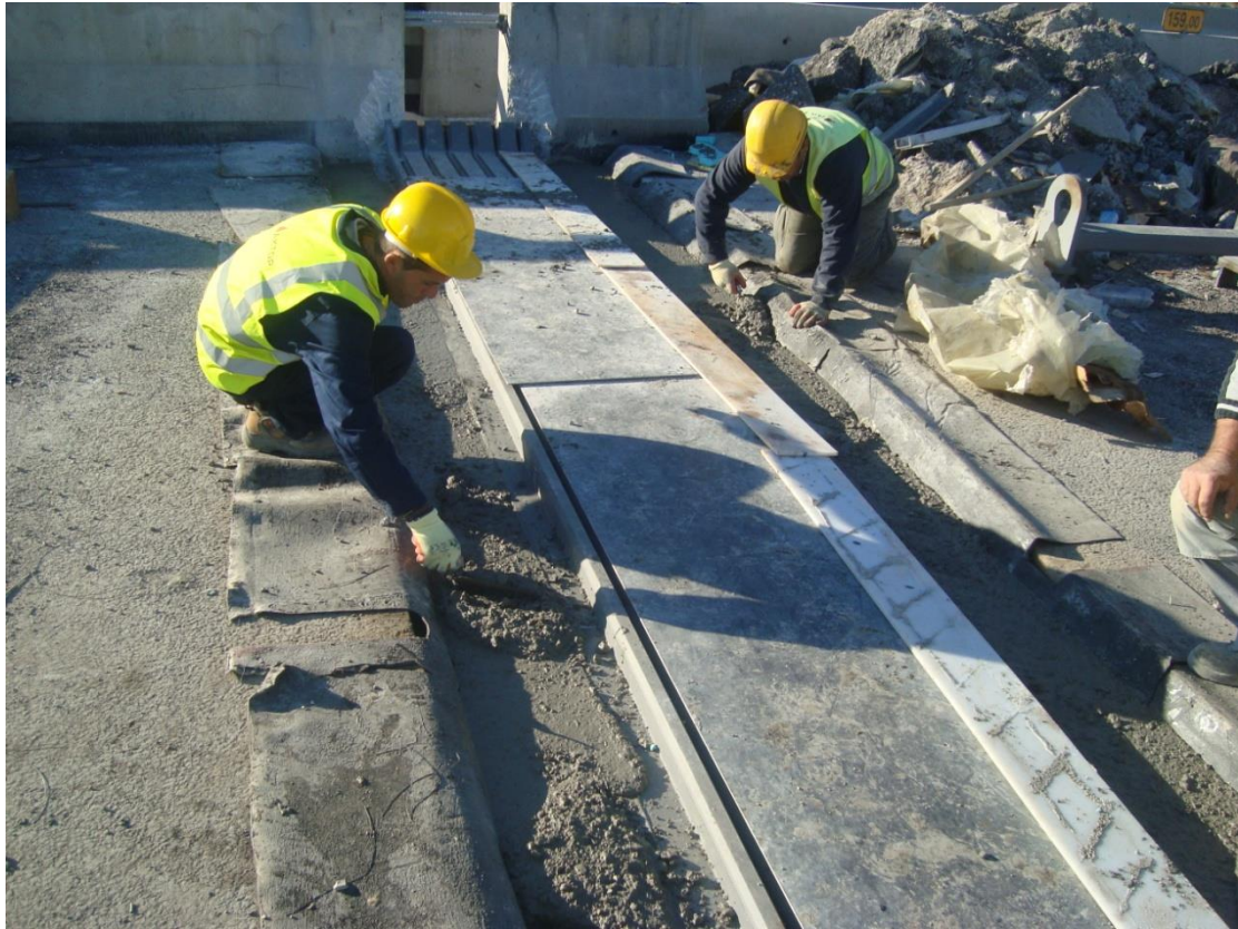
Φωτογραφία 5.13 Πλήρωση αρμού.
