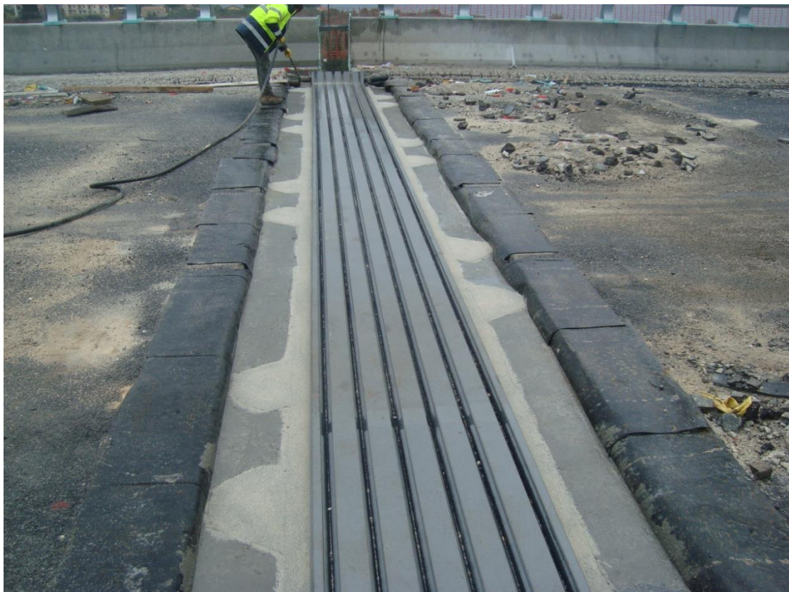
Φωτογραφία 5.14 Ολοκλήρωση αρμού - συνέχεια προηγούμενης φωτογραφίας.
