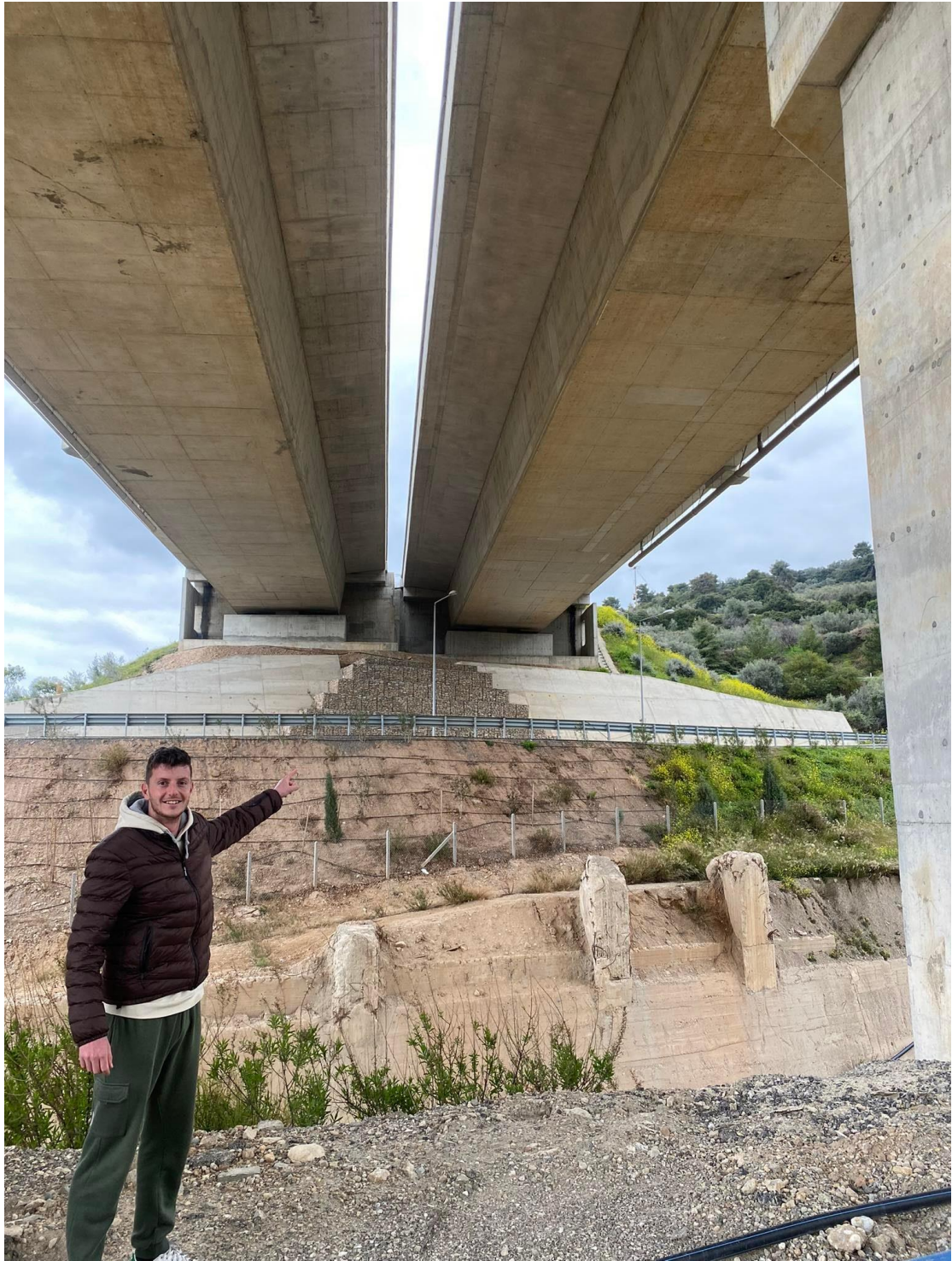
Φωτογραφία 5.32 Όψη κάτω από την γέφυρα, μετά την περάτωση των εργασιών. Λήψη 2022.
