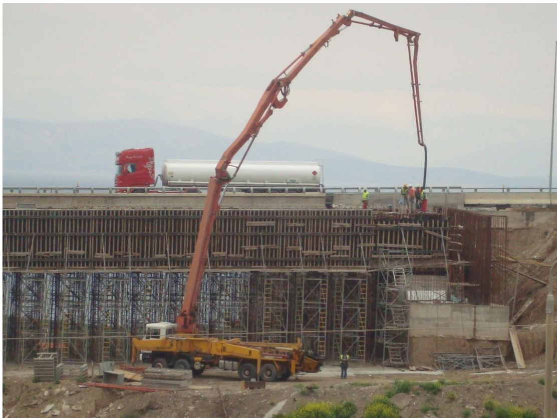
Φωτογραφία 5.10 Σκυροδέτηση ανοίγματος.
