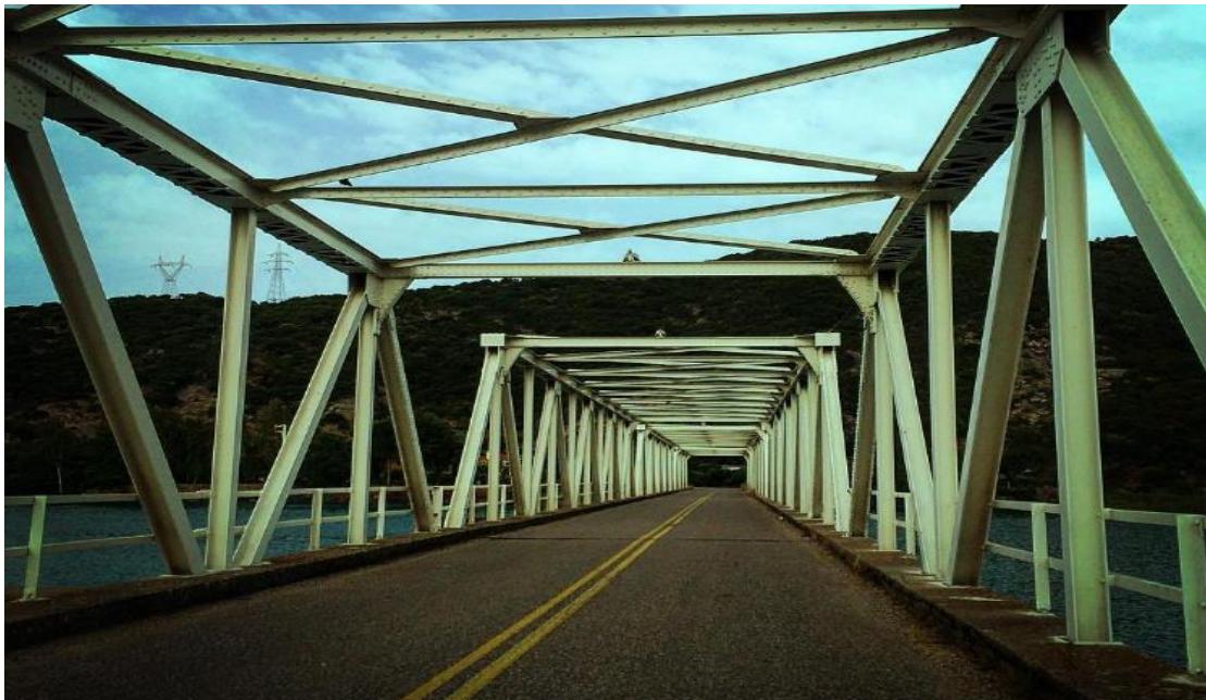
Εικόνα 1.14. Η μεταλλική γέφυρα Μαρσουλίου στον Αχελώο [ link 14 ].
