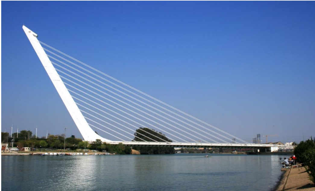
Εικόνα 1.6. Γέφυρα Αλαμίγιο, καλωδιωτή γέφυρα στη Σεβίλλη της Ανδαλουσίας, Ισπανία [link 6].
