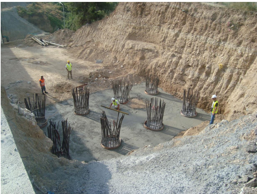
Φωτογραφία 5.4 Σκυροδέτηση φρεατοπασσάλων.
