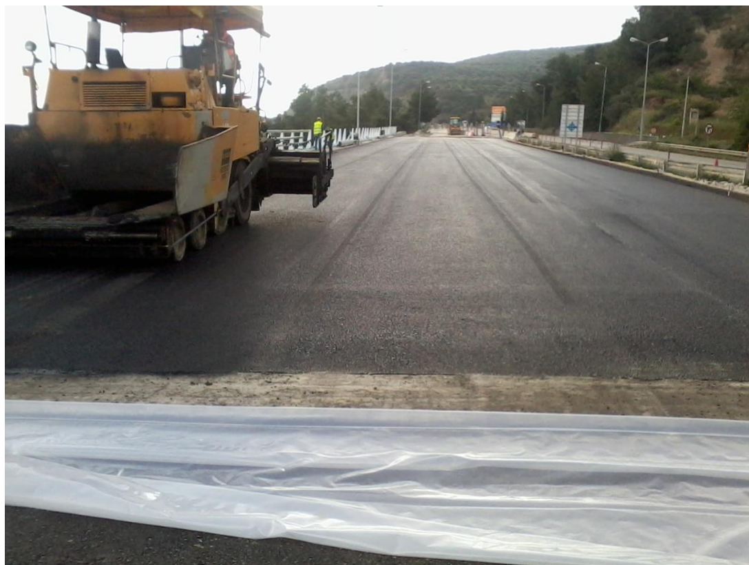
Φωτογραφία 5.24 Finisher κατά την διάρκεια της ασφαλτόστρωσης.
