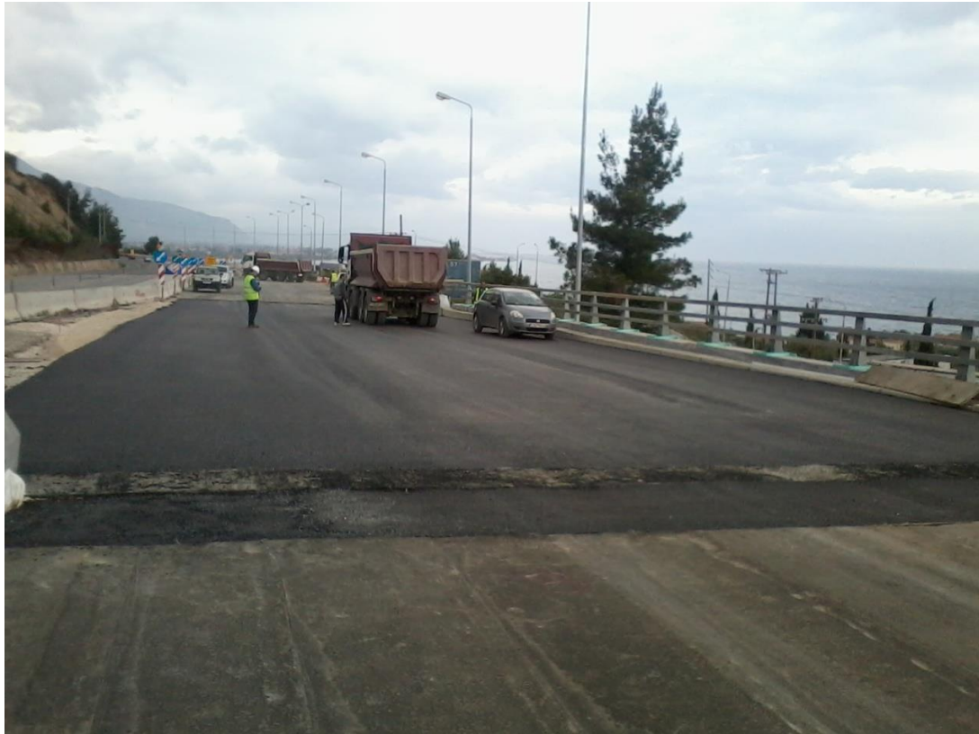
Φωτογραφία 5.23 Ασφαλτόστρωση καταστρώματος.
