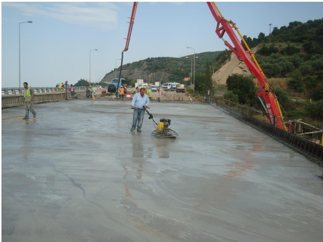
Φωτογραφία 5.12 Δόνηση - επιπεδοποίηση σκυροδέτησης ανοίγματος.
