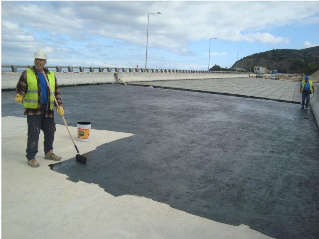
Φωτογραφία 5.21 Επάλειψη υγρομονωτικού υλικού.
