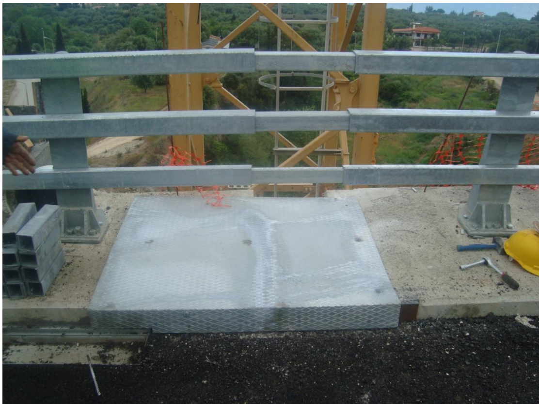
Φωτογραφία 5.28 Τοποθέτηση προστατευτικών στην διατομή των αρμών.
