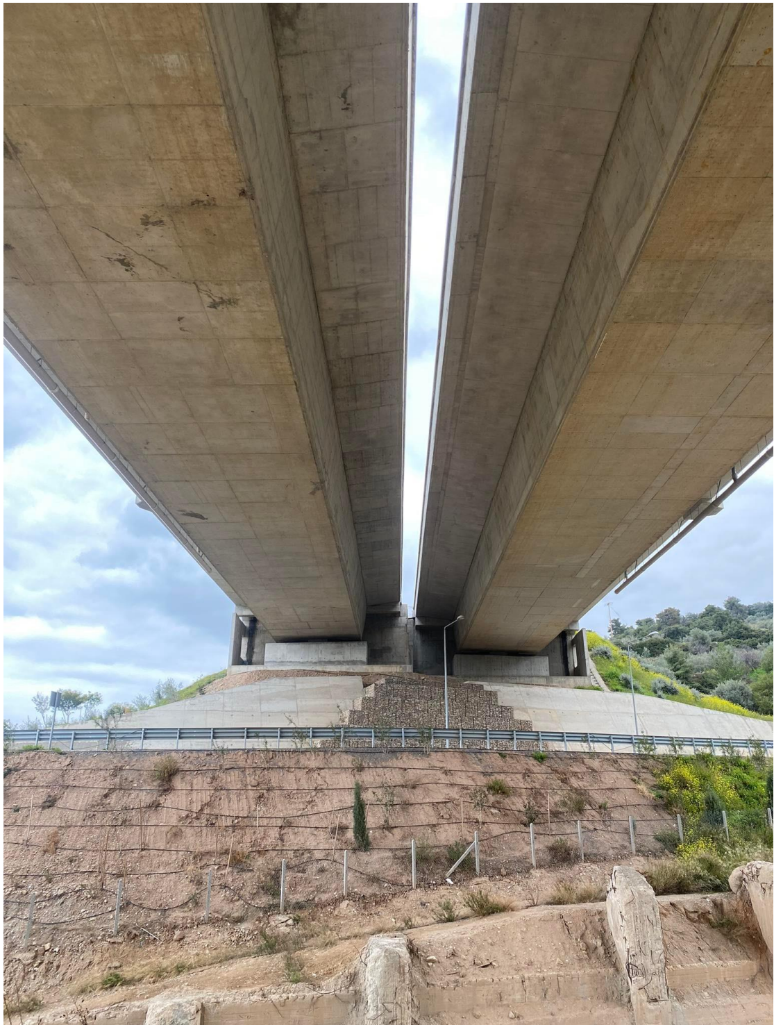
Φωτογραφία 5.35 Όψη κάτω από την γέφυρα, μετά την περάτωση των εργασιών. Λήψη 2022.
