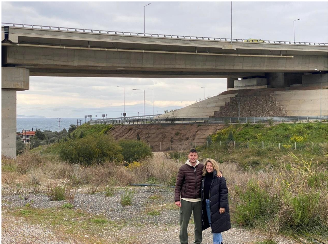
Φωτογραφία 5.37 Πλάγια όψη γέφυρας, μετά την περάτωση των εργασιών. Λήψη 2022.
