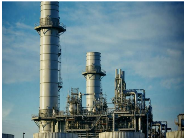
Εικόνα 7: Αντιδραστήρας αναμόρφωσης ατμών
